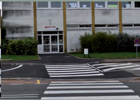
Création d'un passage PMR rue de Rome
