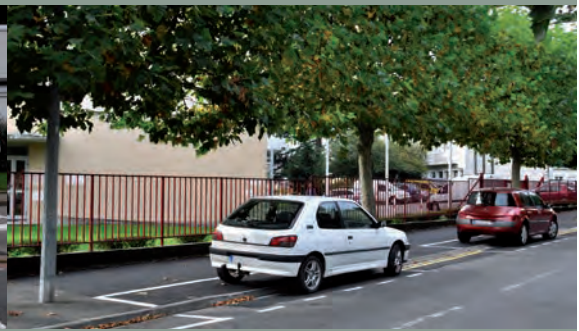
Réfection de voirie rue Jules Ferry
