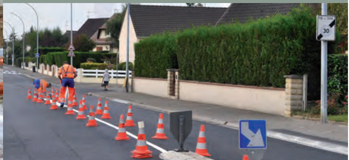
Réfection de voirie rue de Gascogne
